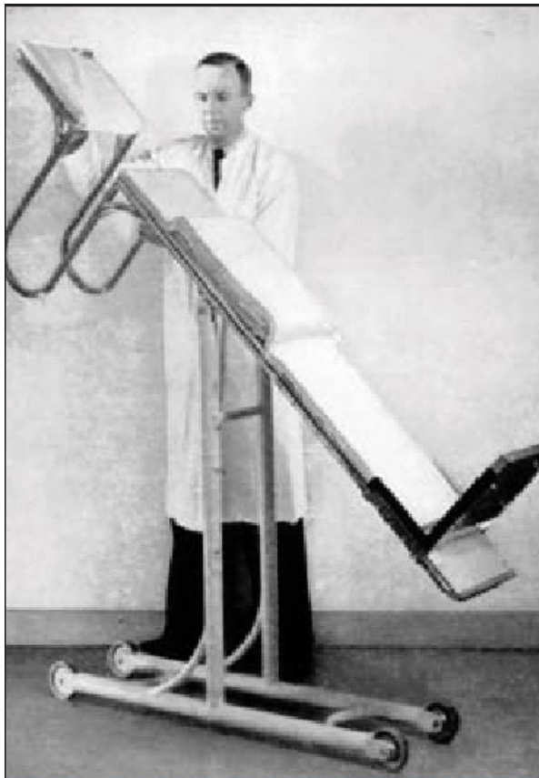
Figuur 2: De metalen wip met constructeur de heer Klein te Leiden. Zie de verstelbare voetenslank en de ophoging voor de heup, zodat patiënt goed kon ademhalen. De boog die het hoofdsteek verbindt met de rest, is ook het handvat van de persoon die de wip beweegt.
